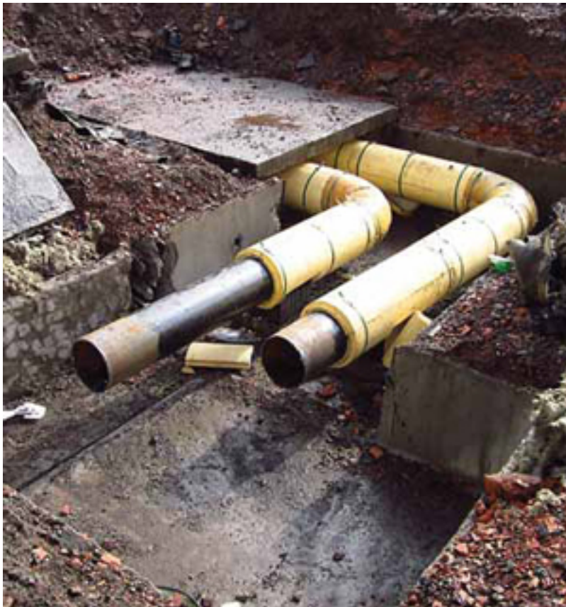
Нижне-Волжское управление Ростехнадзора провело проверку ООО «Теплосети» (Суруикино Волгоградской обл.)
