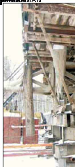
На буровой установке
